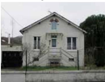
La tuile mécanique, la pierre, la pierre meulière, le moellon calcaire enduit et la brique constituent les matériaux de construction des maisons XIX<sup>ème</sup> - début XX<sup>ème</sup>. Les modénatures tels que : corniches, bandeaux sont en plâtre, parfois en brique. Les linteaux sont souvent en métal ouvragé. Les encadrements sont en brique, pierre ou moellon enduit.
