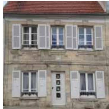
La pierre de taille est visible sur les chaînages d'angles, soubassements ou linteaux. Lorsqu'elles ne sont pas enduites totalement ou à " pierre-vue ", les maçonneries appareillées peuvent être layées, bosselées...
