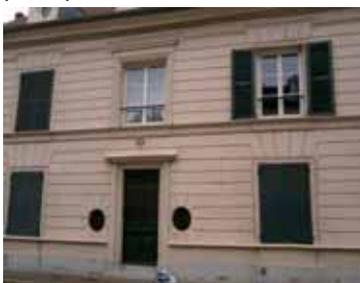
La tuile plate en terre cuite, parfois l'ardoise, le moellon calcaire enduit constituent les matériaux de construction des grandes maisons. Les modénatures tels que corniches, bandeaux, pilastres sont la plupart du temps en plâtre. Les encadrements de fenêtre sont en moellon enduit, parfois en pierre.
