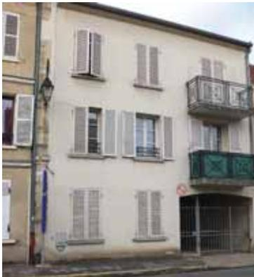
La construction forme un parallélépipède rectangle généralement sur trois niveaux, surmonté d'un toit à deux pans entre 35° et 45°. Il est parfois encadré de souches de cheminée maçonnées.
