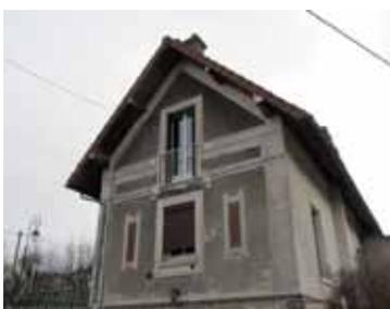
La tuile mécanique, l'ardoise, la pierre, le moellon calcaire enduit, la brique mais aussi le métal constituent les matériaux de construction des villas. Les modénatures tels que : corniches, bandeaux, linteaux, balcon, sont en brique, pierre, parfois en métal ou en béton. Les encadrements de fenêtres sont en brique ou pierre.
