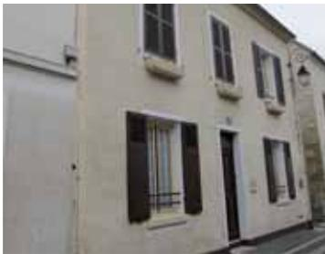
La construction forme un parallépipède rectangle sur deux niveaux, surmonté d'un toit à deux pans entre 35° et 45°. Il est parfois encadré de souches de cheminée maçonnées.
