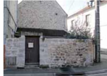
Les murs de clôture des maisons du centre-bourg sont construits en grès ou en moellon calcaire apparents ou recouverts d'un enduit à la chaux, parfois en brique. Ils sont protégés des intempéries par un couronnement maçonné en pierre, en enduit, en brique ou un chapéon en tuile.
