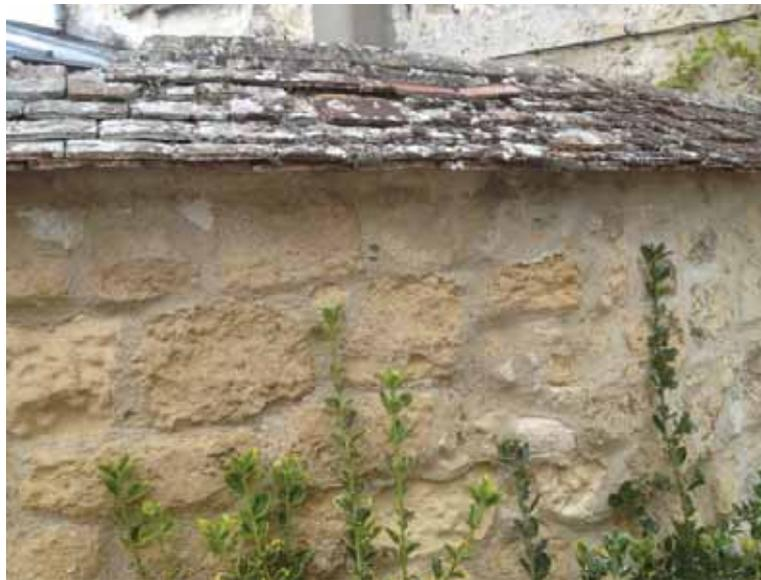
Les couvertures traditionnelles de Viarmes sont généralement en tuile plate petit moule (60 à 80 au m<sup>2</sup> environ) parfois en tuile mécanique (inférieur à 20 au m<sup>2</sup>), rarement en ardoise. Le faitage des tuiles est scellé au mortier clair avec des tuiles demi-rondes (faitage à crêtes et embarrures). Les rives sont souvent protégées par un solin maçonné appelé la ruellée. Celle-ci empêche la pluie de s'infiltrer sous la tuile.
