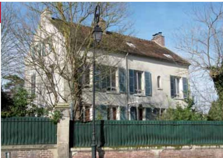
Les façades sont composées avec ordonnancement : alignement horizontal des linteaux et des appuis, superposition et hiérarchisation des ouvertures. Les fenêtres sont souvent beaucoup plus hautes que larges. La porte d'entrée est généralement composée de deux vantaux.
