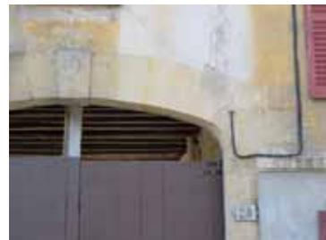
Sur les murs de moellon, harpe et chaînage d'angle en pierre de taille, voire brique, linteaux et jambages renforcent la maçonnerie.
