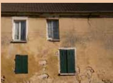
Si des fissures apparaissent (murs, planchers, charpente...), il faut en rechercher la cause : dilatation des matériaux, désordres d'ordre structurels, mouvement de sol, structure trop faible. Il peut être utile de faire une étude de sol si besoin et demander conseil à un ingénieur structure aussi bien pour les parties maçonnées que pour les pièces de charpente en bois.
