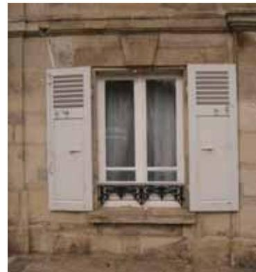
Les volets battants des fenêtres s'encastrent généralement dans les feuillures ménagées à l'extérieur des tableaux. Ils sont réalisés en bois peint parfois métalliques pliants, persiennés le plus souvent sur la moitié de la hauteur au rez-de-chaussée et en totalité à l'étage. Généralement, ils sont sous forme de planches assemblées par des barres horizontales sans écharpes.
