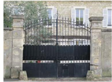
Les murs des clôtures sont généralement protégés par des couronnements en pierre, en enduit, ou en tuiles. Les baies, facteurs de fragilité, font l'objet de nombreux détails soignés : taille, forme, matériau, finition, appareillage...
