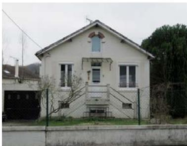
La tuile mécanique, la pierre, la pierre meulière, le moellon calcaire enduit et la brique constituent les matériaux de construction des maisons XIXème - début XXème. Les modénatures tels que : corniches, bandeaux sont en plâtre, parfois en brique. Les linteaux sont souvent en métal ouvragé. Les encadrements sont en en brique, pierre ou moellon enduit.
