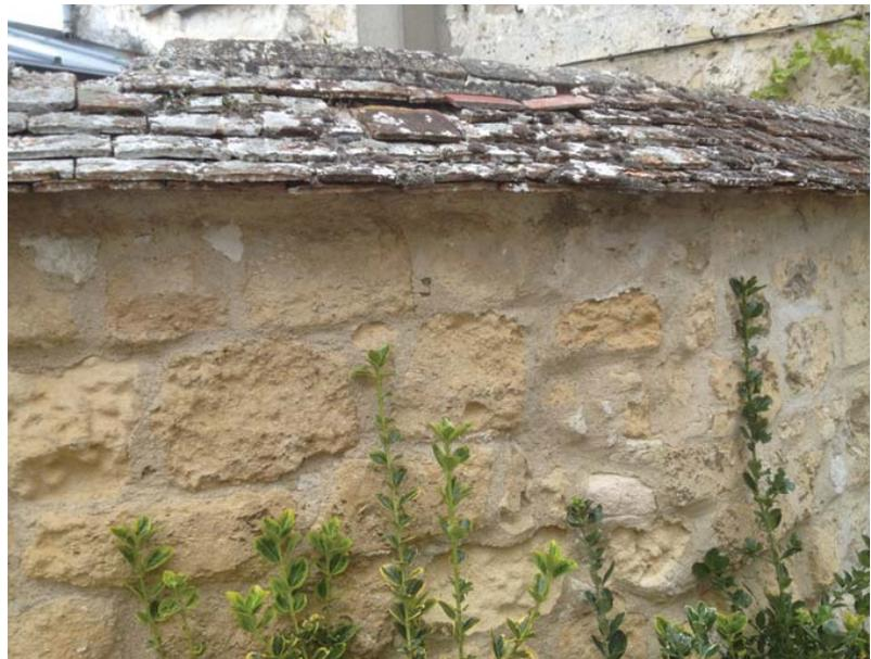
Les couvertures traditionnelles de Viarmes sont généralement en tuile plate petit moule (60 à 80 au m<sup>2</sup> environ) parfois en tuile mécanique (inférieur à 20 au m<sup>2</sup>), rarement en ardoise. Le faitage des tuiles est scellé au mortier clair avec des tuiles demi-rondes (faitage à crêtes et embarrures). Les rives sont souvent protégées par un solin maçonné appelé la ruellée. Celle-ci empêche la pluie de s'infiltrer sous la tuile.
