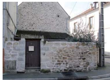
Les murs de clôture des maisons du centre-bourg sont construits en grès ou en moellon calcaire apparents ou recouverts d'un enduit à la chaux, parfois en brique. Ils sont protégés des intempéries par un couronnement maçonné en pierre, en enduit, en brique ou un chaperon en tuile.
