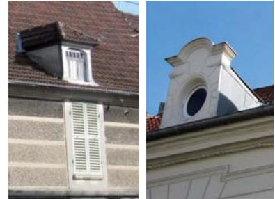
Parfois, des ouvertures dans le toit éclairent les combles. Elles sont diverses : en maçonnerie, en bois, en métal. Elles présentent des formes variées (lucarne, oeil-de-boeuf, oculus, fenêtre de toit...). Leurs menuiseries s'harmonisent avec celles des fenêtres de la façade.
