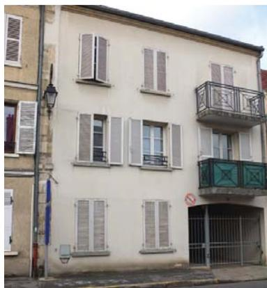
La construction forme un parallépipède rectangle généralement sur trois niveaux, surmonté d'un toit à deux pans entre 35° et 45°. Il est parfois encadré de souches de cheminée maçonnées. La hauteur sous gouttière est comprise entre 8 et 12 mètres. La longueur du bâti varie de 7 à 12 mètres sur une largeur oscillant entre 8 à 12 mètres.
