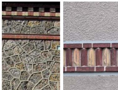
La brique se mêle à la pierre dans les éléments de modénature tels que corniches, bandeaux ou linteaux.
