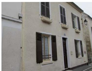
La construction forme un parallélepède rectangle sur deux niveaux, surmonté d'un toit à deux pans entre 35° et 45°. Il est parfois encadré de souches de cheminée maçonnées.
