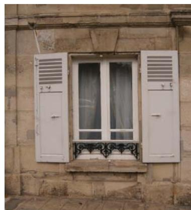
Les volets battants des fenêtres s'encastrent généralement dans les feuillures ménagées à l'extérieur des tableaux. Ils sont réalisés en bois peint parfois métalliques pliants, persiennés le plus souvent sur la moitié de la hauteur au rez-de-chaussée et en totalité à l'étage. Généralement, ils sont sous forme de planches assemblées par des barres horizontales sans écharpes.
