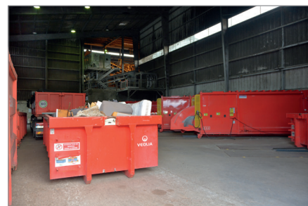
Le hall de tri des encombrants
