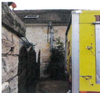
Continuité du bâti avec la parcelle AC 726
