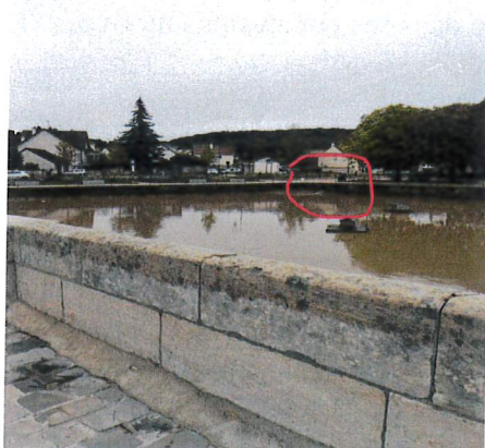
Alimentation de l'étang en amont
