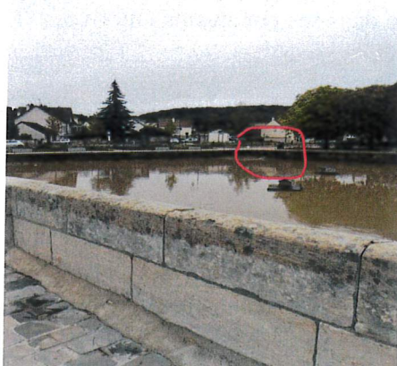
Alimentation de l'étang en amont
