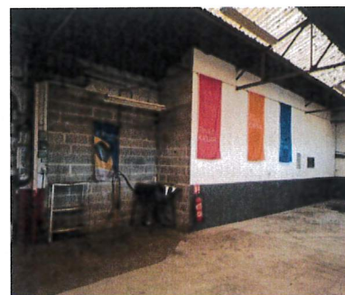
Vue à l'intérieur de l'atelier fond De la parcelle AC 1154
